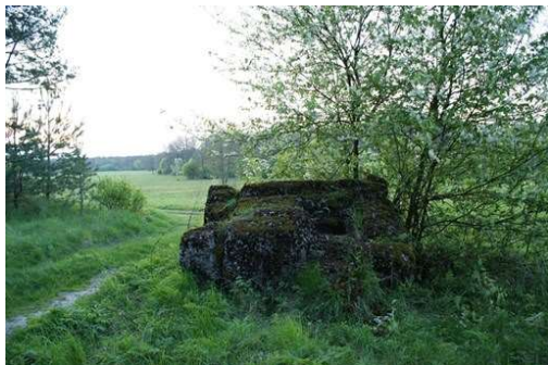
Fot. 02. Bryła żelbetu, ze strzelnicą ckm, stanowiąca niegdyś fragment ściany bocznej. Widoczna jest wyraźnie zarysowana linia fundamentu, a także fragment pancernia niegazoszczelnego (pośrodku bryły). Fot. Dominik Kasprzak, Marcin Kasprzak.
