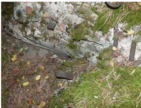
Fot. 07. Destrukt strzelnicy broni ręcznej ze stopniowaniem przeciwykoszetowym. Wskazuje na to ułożenie kotew oraz ślad w betonie. Fot. Łukasz Drzensła.
