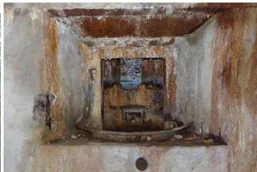
Fot. 03. Nieuszkodzona strzelnica ckm za pancernem niegazoszczelnym typu 39 w połowym schronie żelbetowym w Wólce Piasecznej. Takie samo stanowisko znajdowało się w schronie Mątwnica. Fot. Łukasz Drzensła.
