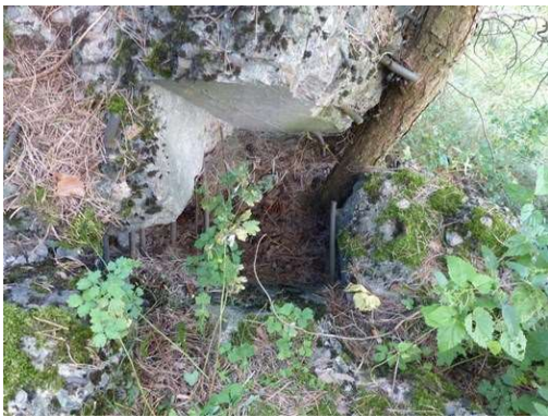
Fot. 04. Destrukt kanału technologicznego na rury łączności optycznej w schronie dla armaty 75 mm. Fot. Łukasz Drzensła.
