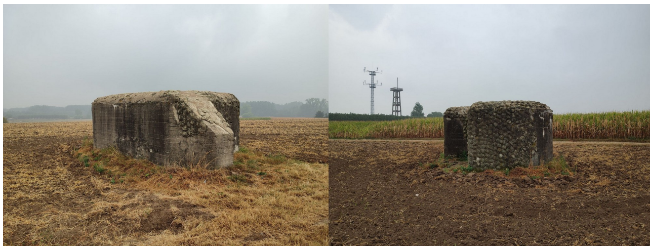
Fot. 14. Widok od czoła z ukosa na orylon. Fot. 15. Ściana boczna schronu Mu 19 z dobrze Wyraźnie widoczne maskowanie wykonane zachowanym tynkiem maskującym typu Tyrolien betonowego tynku. Warto zaznaczyć że Mamelonné pozbawiona już jednak współcześnie maskowano również ścianę czołową costosownego farbomaskowania. spowodowane było brakiem stosowania nasypów ochronno-maskujących.
