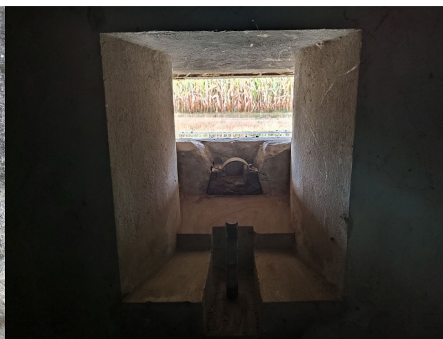
Fot. 12. Widok na strzelnicę. U dołu widoczne są zawiasy od współcześnie już nieistniejącej płyty. Wyraźnie widać czop dla lawety typu Charome. Warto zwrócić uwagę na zachowane fragmenty oraz drewniany zamykany segment dla stabilizacji przedniej nogi trójnożnej podstawy polowej dla karabinu FM 30.
