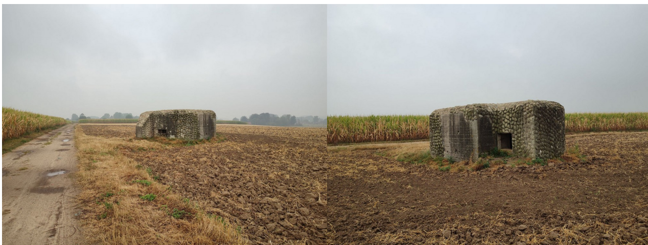
Fot. 02. Widok na obiekt od strony zapola naFot. 03. Widok na wejście do obiektu, niestety ze skrzydło punktu oporu, wyraźnie widoczny jest demontowanymi drzwiami kratowymi. Przed masywny orylon chroniący strzelnicę od wejściem znajdowała się studnia zabezpieczająca ukośnego ognia z przedpola. obiekt przed zalaniem – dziś niestety zasypana.
