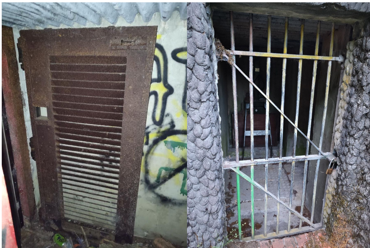
Fot. 10. Wewnętrzne drzwi pancerne jednego ze schronów na przedpolu Antwerpii, mimo słabego stanu zachowania reprezentują one typ zsię w obiekcie Mu 19. Fot. 11. Drzwi kratowe schronu Sluisbunker A20 na przedpolu Antwerpii - identyczne znajdowały się w ramie strzelnicą.
