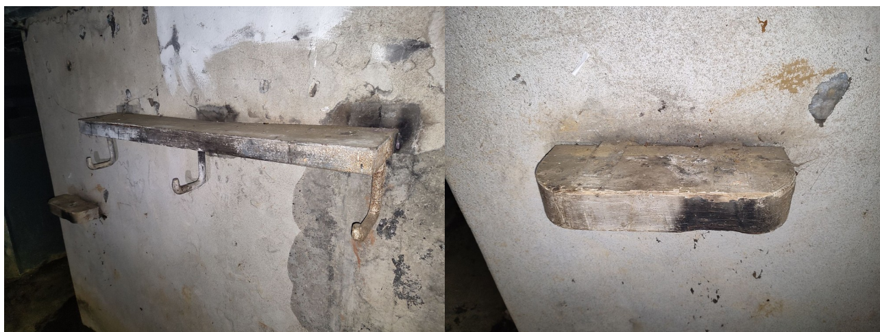
Fot. 06. Nowsze rozwiązanie półki wraz z hakami Fot. 07. Stolik dla ładowarki taśmy amunicyjnej na wyposażenie z jednym mocowaniem dla CKM, znajdujący się na ścianie naprzeciwko strzelnicy (zdjęcie pochodzi z innego obiektu względem poprzedniego (gdzie haki oraz półki albowiem w Mu 19 stolik nie zachował się). Rozwiązanie to zdaje się być bardziej optymalne (występowały oddzielnie zajmując więcej miejsca).
