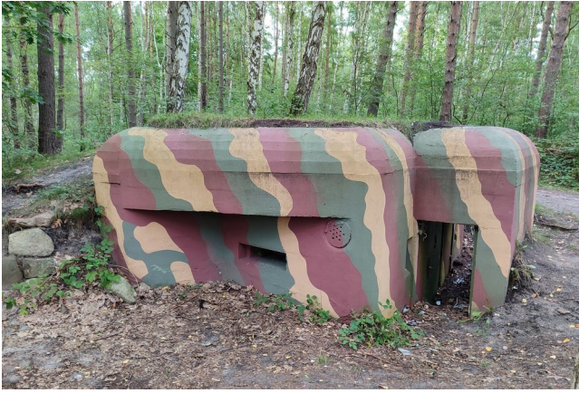
Fot. 16. Polski jednostronny schron bojowy drugiej linii punktu oporu Jastarnia. Obiekt schron bojowy nowego typu (XIX/425/D2) poprzez wybudowanie w kategorii zwany popularnie „řopíkem”. Czechosłowacki „wzmocnionej” reprezentował bardzo zbliżony obiekt górował w każdym aspekcie, ustępując poziom do obiektu belgijskiego. jednak stopniem odporności (nawet dla kategorii zesilený/wzmocniony).
