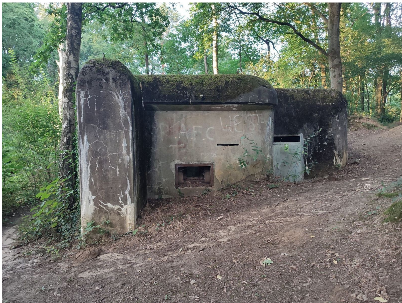
Fot. 20. Widoczny na zdjęciu Abri Mi. Double (Schans Schilde) jest schronem późniejszej generacji względem obiektu Mu 19, tym samym naprawiono część poprzednich wad - dodano szczelinę obserwacyjną czym znacznie poprawiono warunki obserwacji i prowadzenia ognia oraz wykonano okap ochronny.
