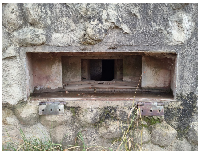
Fot. 12. Widok na strzelnicę. U dołu widoczne są zawiasy od współcześnie już nieistniejącej płyty. Wyraźnie widać czop dla lawety typu Charome. Warto zwrócić uwagę na zachowane fragmenty oraz drewniany zamykany segment dla stabilizacji przedniej nogi trójnożnej podstawy polowej dla karabinu FM 30.
