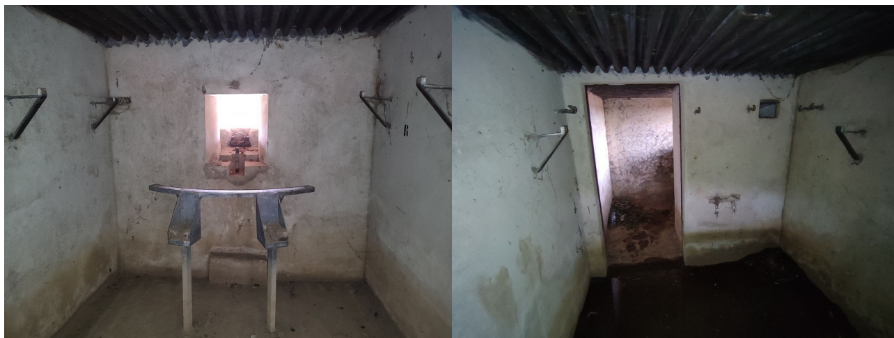
Fot. 04. Izba bojowa schronu Mu 19, wyraźnie widać strzelnicę wraz z elementem lawety wobiektu. Na ścianach znajdują się mocowania dla postaci zabetonowanych profili stalowych półek oraz haki na indywidualne oporządzenie stanowiących podstawę dla listwy oporowej wraz z żołnierzy. W prawym rogu izby pod stropem z segmentami dla tylnych nóg lawety podstawy znajduje się zrzutnia granatów. polowej karabinu FM 30.
