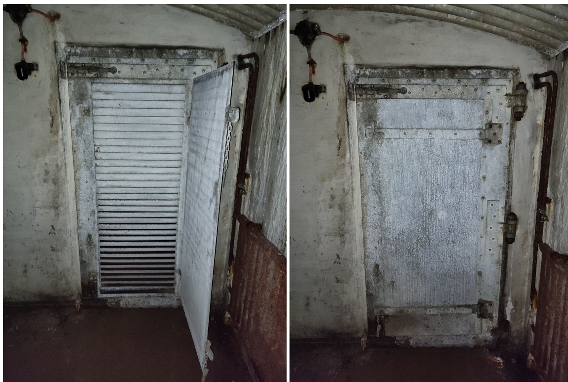
Fot. 08 i 09. Dobrze zachowane znajdujące się w podziemiach fortu d'Aubin-Neufchâteau drzwi pancerne. Na pierwszym zdjęciu z widoczną otwartą płytą do całkowitego zamknięcia - co ułatwiało wentylację, na drugim zaś z zamkniętą zapewniającą dodatkową ochronę przeciw podmuchowi.
